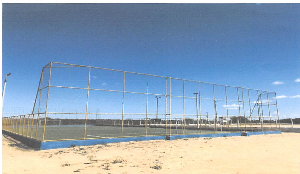
Foto Nº 02/06 Areninha – estádio Carneirão
